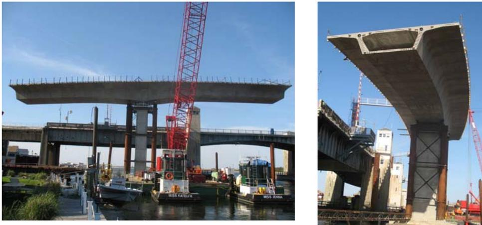
Fig. 9 Pier 3 Cantilever
